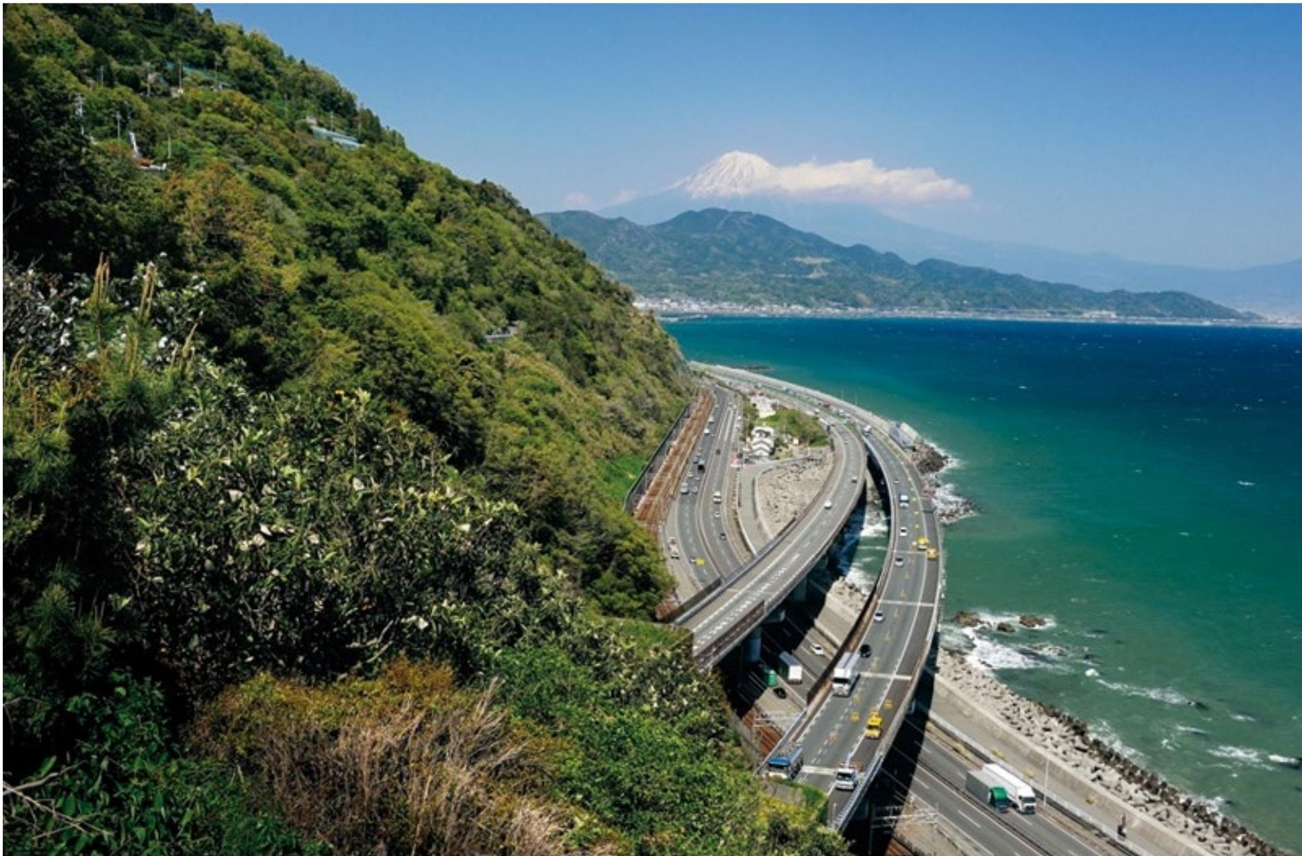
写真左上に上の写真の現場がある。地すべりの状況は国土交通省が遠隔監視しており、変位を観測した場合、自動的に道路と鉄道の各管理者に情報提供する（写真：大村拓也）
